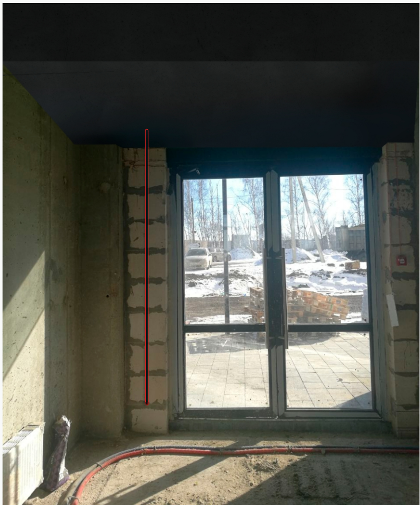
Вывод конденсаторной трубки у кондиционера внутри здания (ул. Яшиной д.2, д.4)
