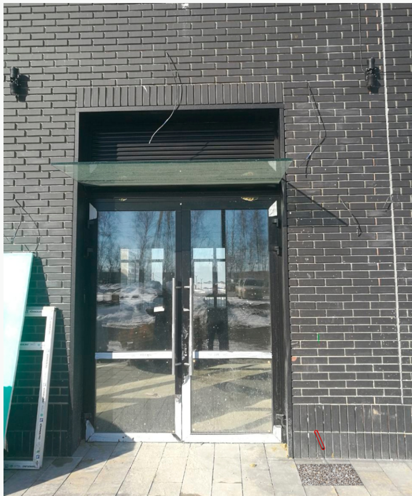
Вывод конденсаторной трубки у кондиционера со стороны улицы (ул. Яшиной д.2, д.4)
